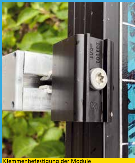
Klemmenbefestigung der Module
