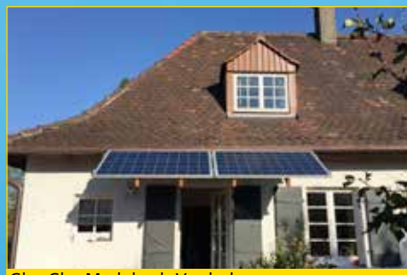
Glas-Glas Module als Vordach
