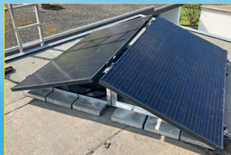
Ost-West Ausrichtung mit zwei Modulen auf Flachdach.
