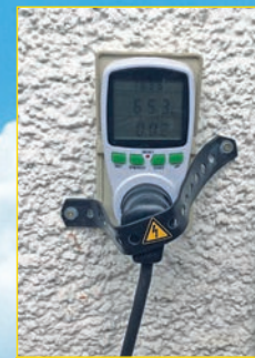
Einspeisesteckdose mit mechanischer Trennsicherung
