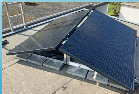
Ost-West Ausrichtung mit zwei Modulen auf Flachdach.
